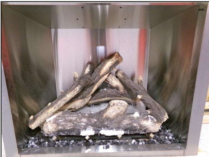
7. Après l'installation des bûches, placez les roches de lave/charbon de bois fournies autour des bûches sur le sol du foyer. Assurez-vous que les roches de lave/charbon de bois ne recouvrent aucun des ports de brûleur.
